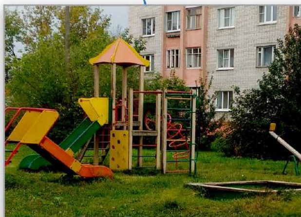
Отремонтирована детская площадка на ул. Аэродромная
